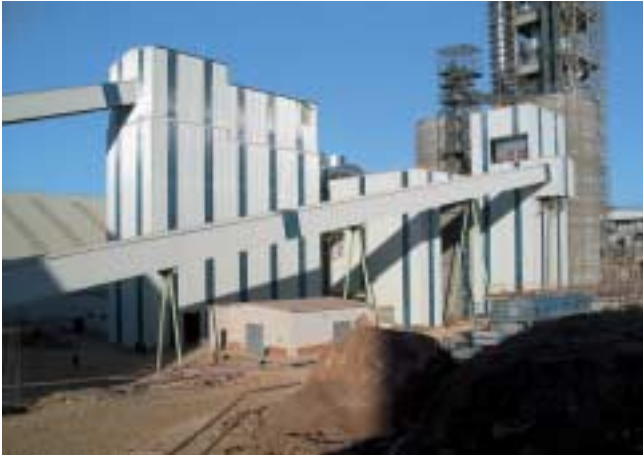
1 Gebäude der Rohmaterialbunker, der Rohmehlmahlanlage sowie der Kohlemahlanlage 1 Building accommodating the raw material bins, the raw meal grinding plant and the coal grinding plant
