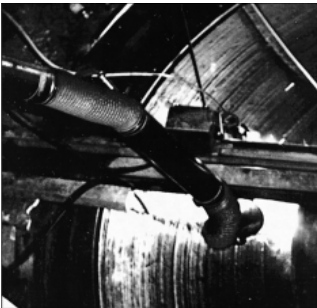
BILD 4: Auftragschweißen von Mahlplattensegmenten in der Mühle FIGURE 4: Hardfacing grinding plate segments in the mill
