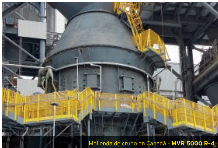
Molienda de cemento en Argelia - MVR 6700 C-6
