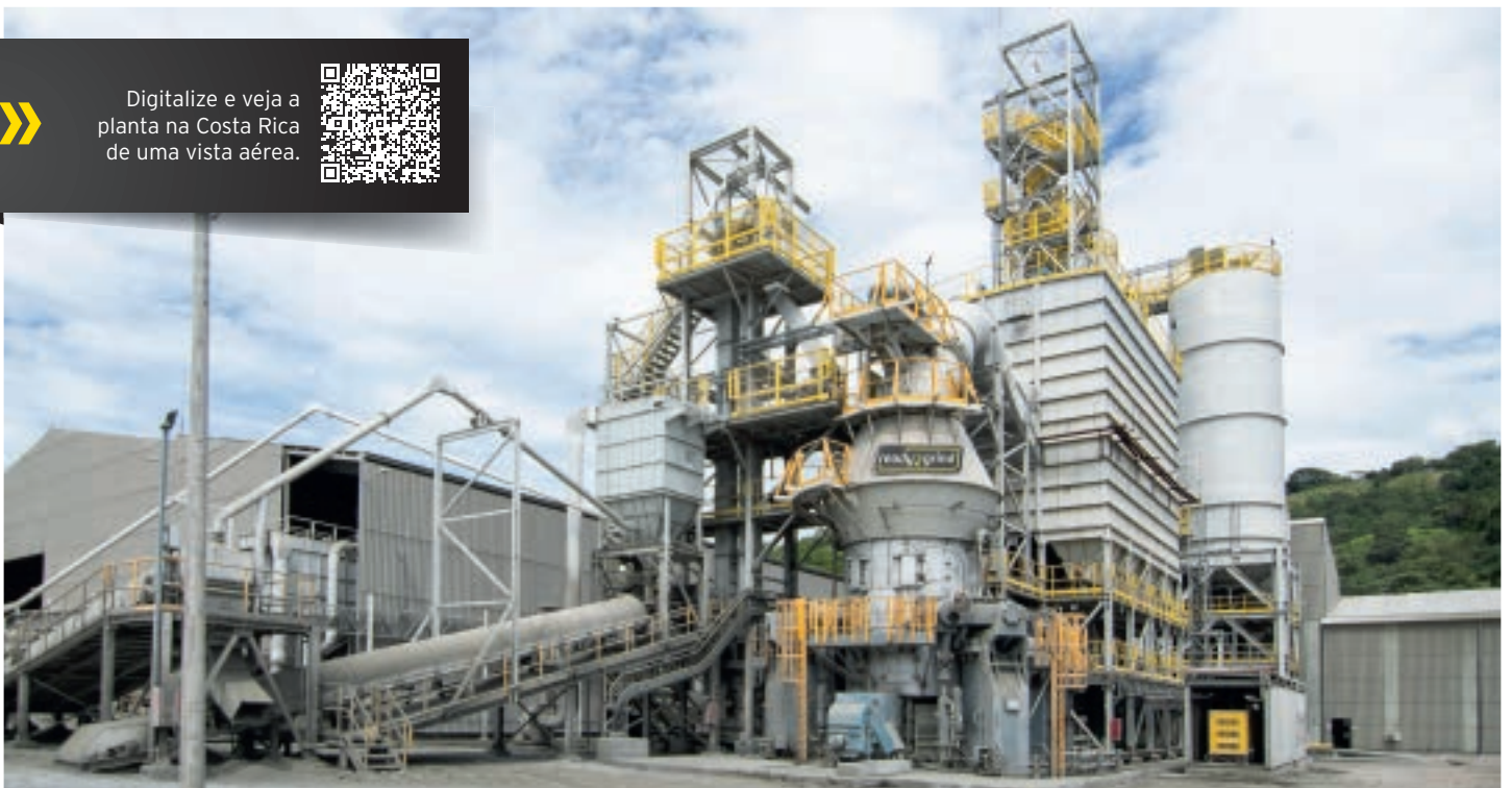
R2G 2500 C-4: O coração do ready2grind na Costa Rica é, como sempre, um moinho MVR com 4 rolos de moagem.
