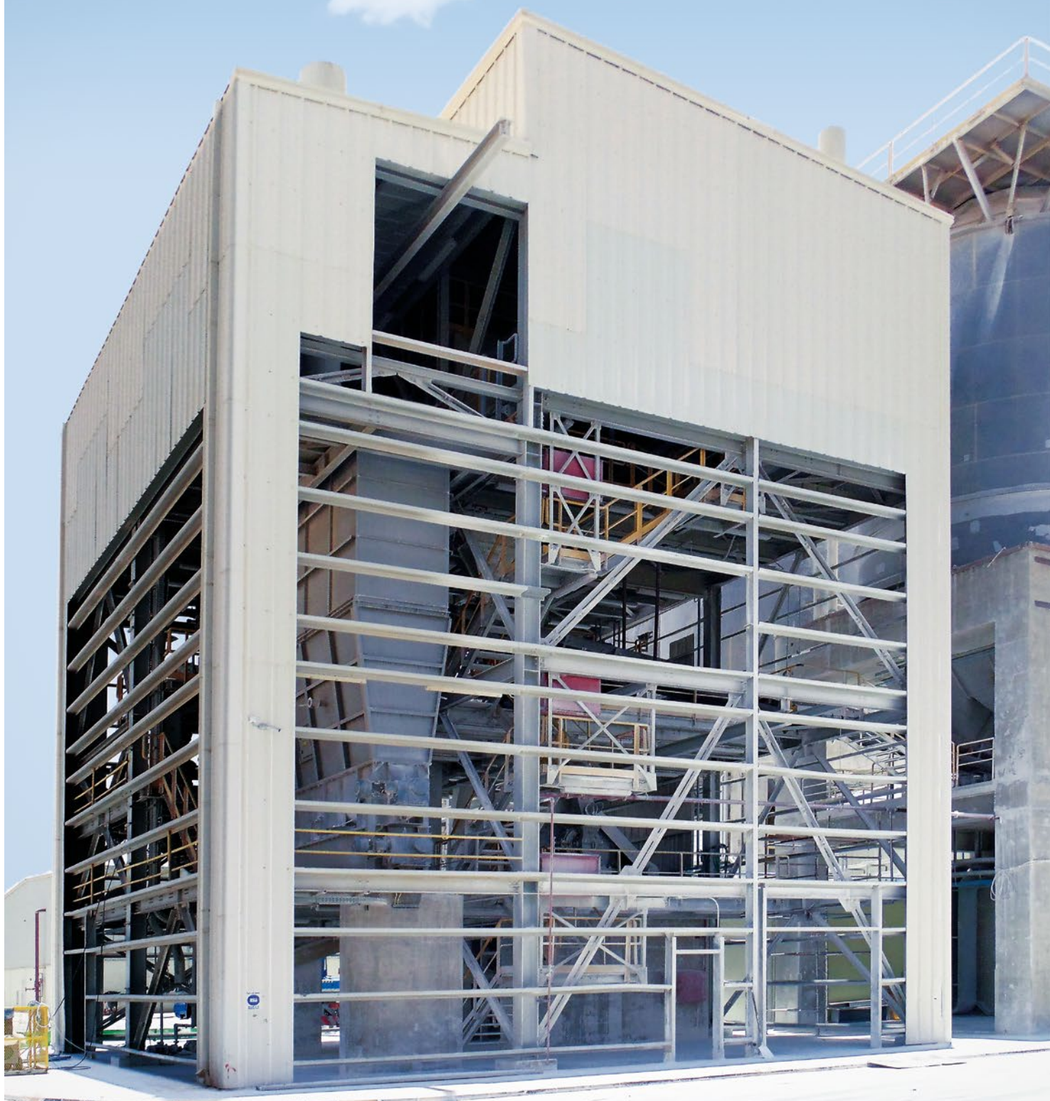
Planta de hidratação de cal na Arábia Saudita, incluindo separador de alta eficiência SLV, moinho de bolas MRD e hidratador de cal KLV
