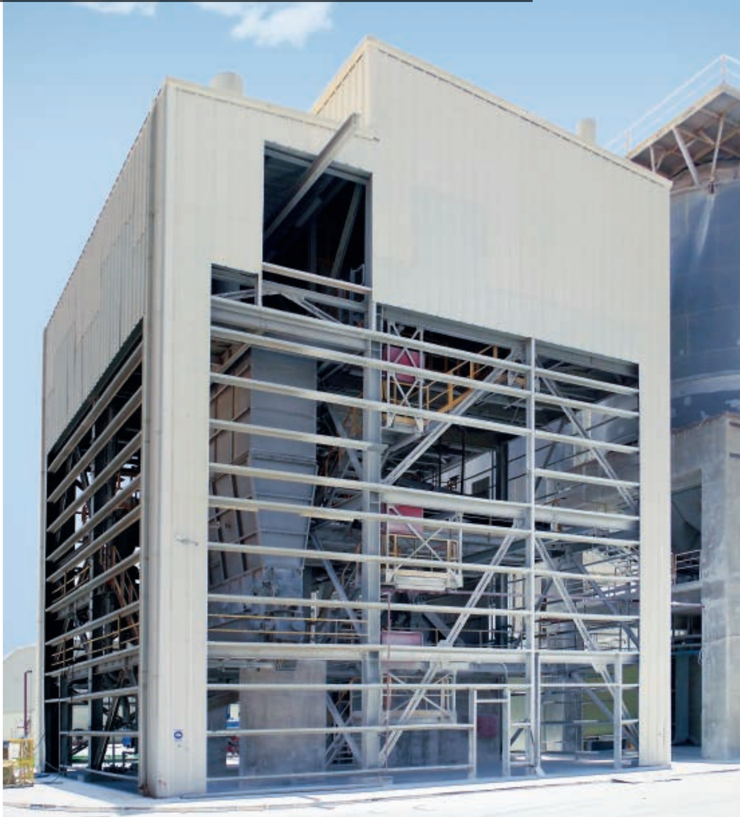
Planta de apagado de cal en Arabia Saudí, con separador de alto rendimiento SLV , molino de bolas MRD y máquina de apagado de cal KLV
