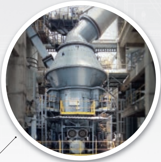
Kohlemahlung mit MPS-Walzenschüsselmühlen
