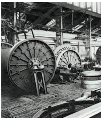
1925 wird die damals größte Zementmühle der Welt ausgeliefert - eine Herausforderung für die Mitarbeiter und spannendes Ereignis für Passanten. In der Fertigungshalle reihen sich die Doppelhartmühlen aneinander.
